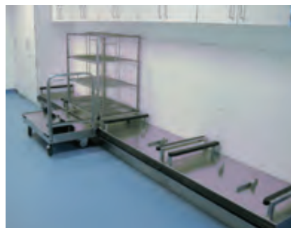
Sterilgutlager mit Elementen des Hammerlit Shuttle-Systems
